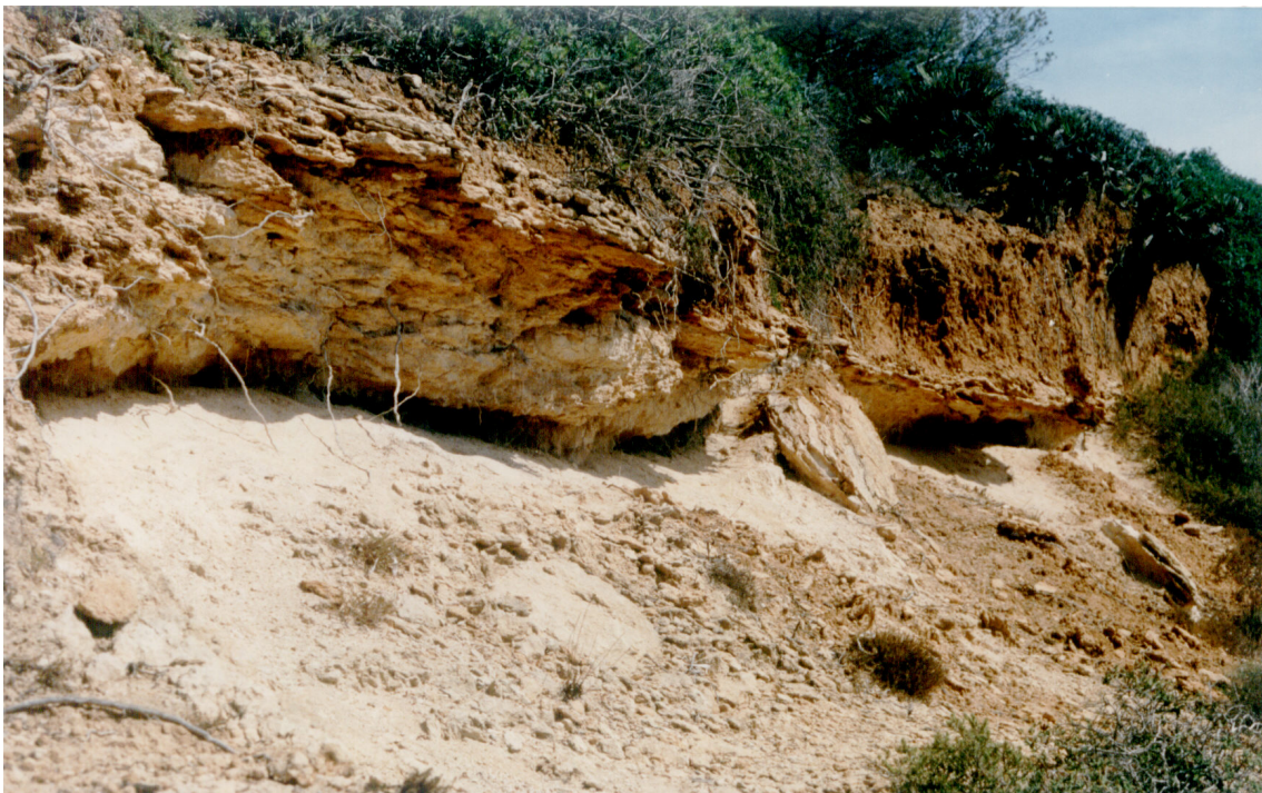
Abb. 29: Weiße Mergel unsicherer Altersstellung im Bereich des Kreidegrabens der Punta Negra, Vorkommen: s. Lagekarte der Profilstrecken und Aufschlußphotos, Anhang.
